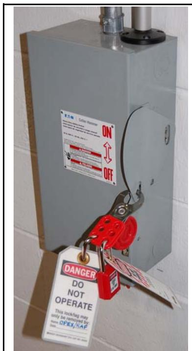
**Figura 2-17: Esempio: sezionatore principale AC con Lockout/Tagout**
